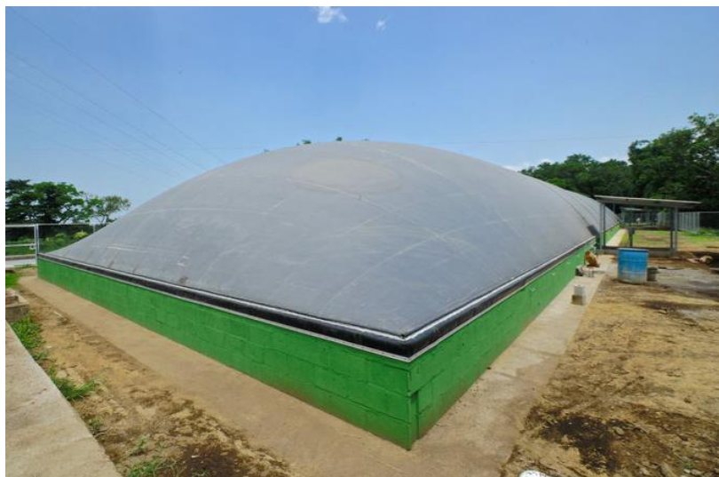
Figura 71. Imagen de una celda de laguna cubierta para materia prima de abono [4].
