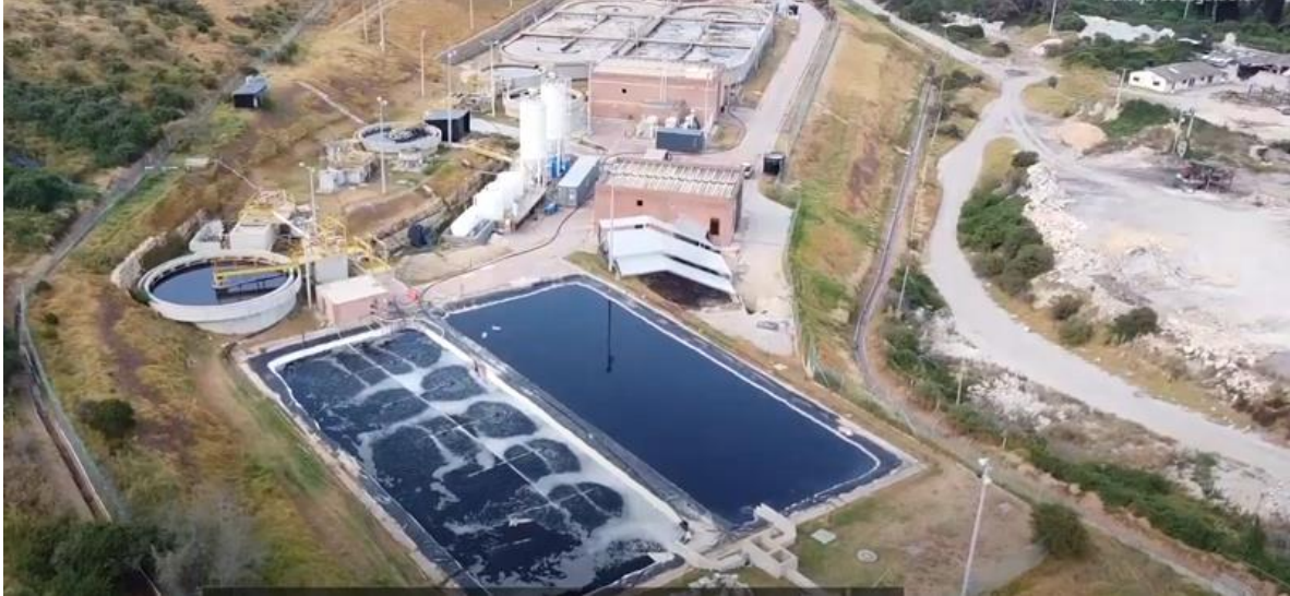
Figura 99. Balsa de captación y tratamiento de lixiviados en el relleno sanitario de Doña Juana [15].
