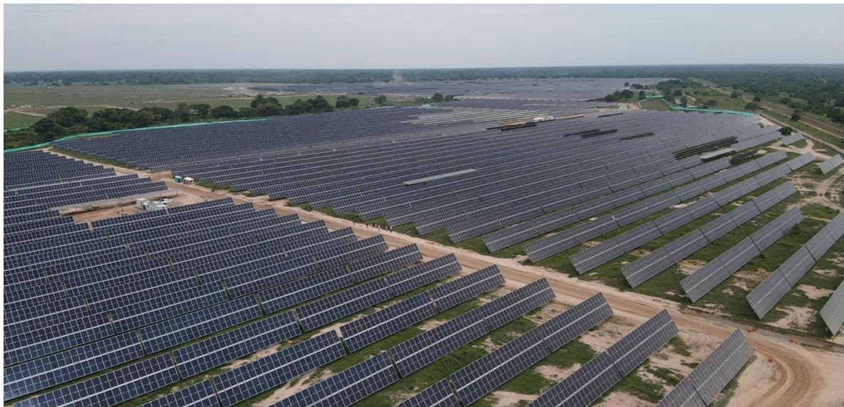
Figura 14. Vista aérea de la Central Solar de La Loma [30].
