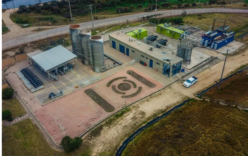
Figura 100. Planta de Gas del Relleno Sanitario de Doña Juana [20].
