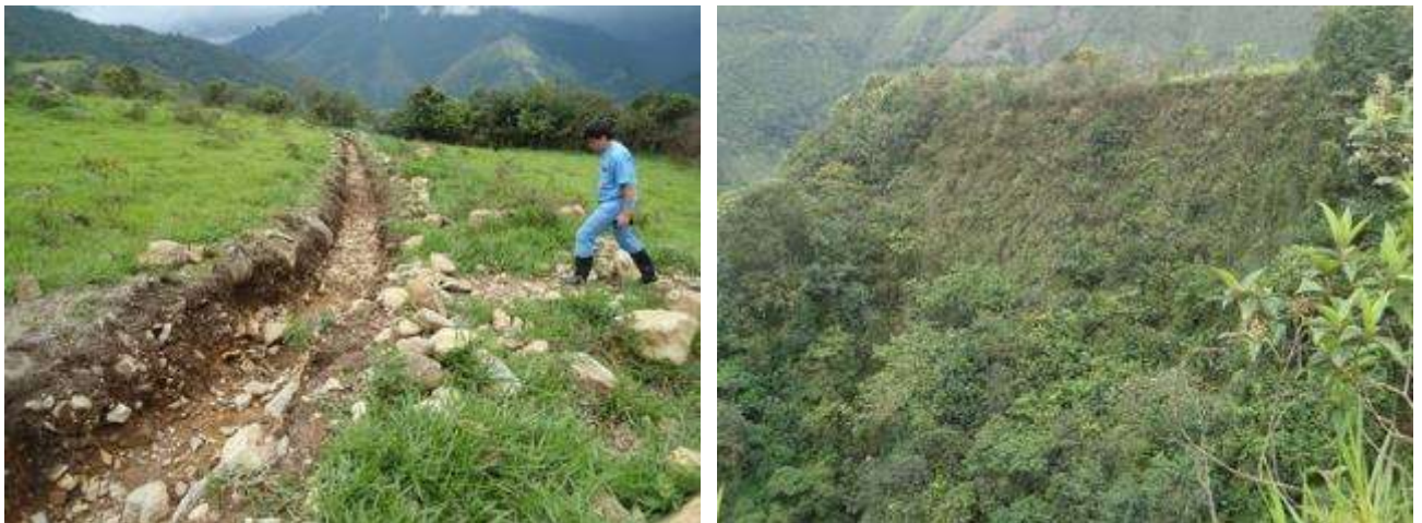
En la parte más baja de la granja avícola se cuenta con una zanja que recoge las aguas de escorrentía superficial en épocas de lluvia. Nótese al fondo en la imagen de la derecha que el descole de esta zanja no presenta afectación alguna debido a los bajos volúmenes que recoge.
