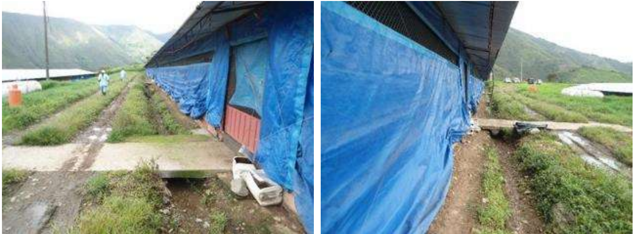
En la Avícola Pollo Olímpico ubicada en la parte alta de la vía al llano, se hace manejo de aguas lluvias de los galpones mediante zanjas en tierra con descoles controlados no perjudiciales en los taludes.
